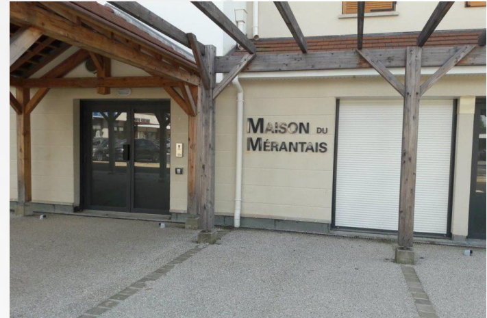
Maison du Mérantais Centre commercial Chamfleury Voisins-le-Bretonneux
